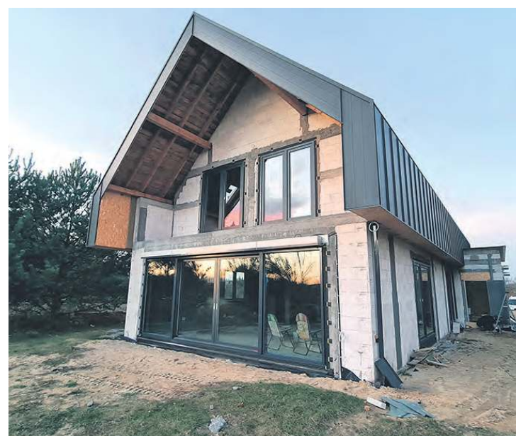
Na parterze aluminiowe drzwi typu slide z roletą podtynkową, na piętrze okna balkonowe PCV.
