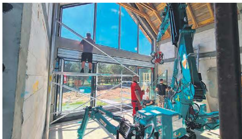
Montaż okien wielkogabarytowych z użyciem dźwigu.
