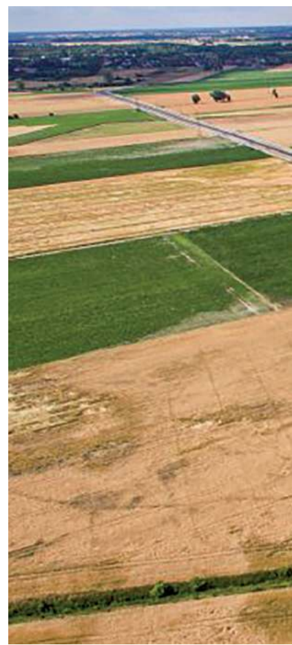
Budowa obwodnicy razem z infrastrukturą kosztowała ponad 26 mln zł.
