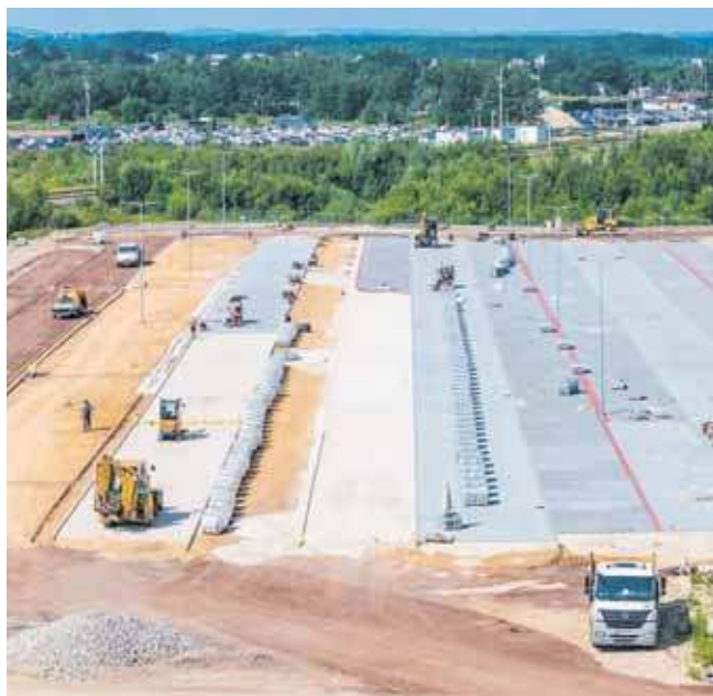
Powstaje 1100 nowych miejsc postojowych
