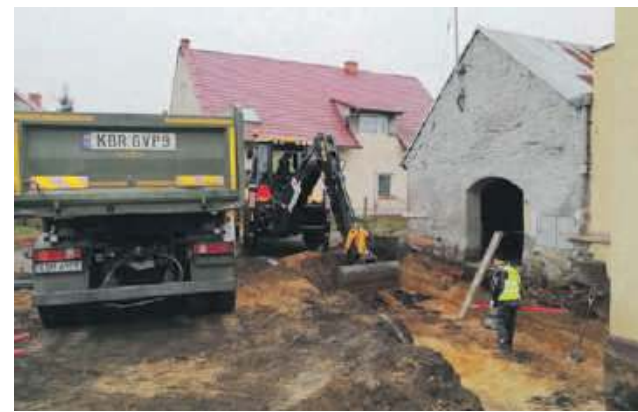
Zakończenie prac budowlanych zaplanowano na koniec września przyszłego roku
