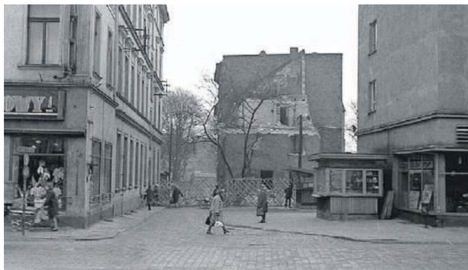
1969 - ul. Głowackiego od Rynku, wyburzanie budynków po prawej stronie
