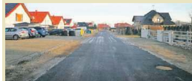
Na ul. Twardowskiego została położona mieszanka mineralno-bitumiczna.
