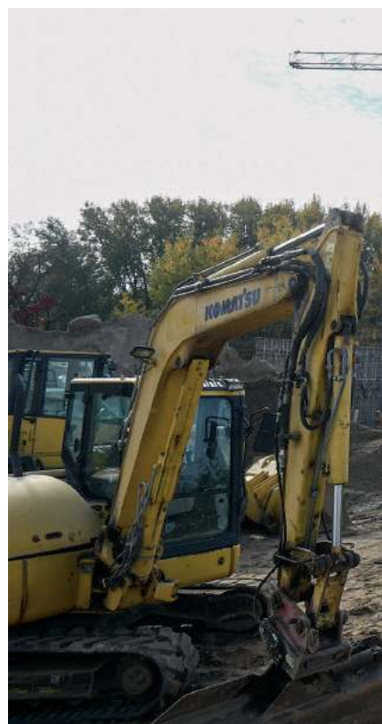
Budowana szkoła ma być przeznaczona dla 750 uczniów
