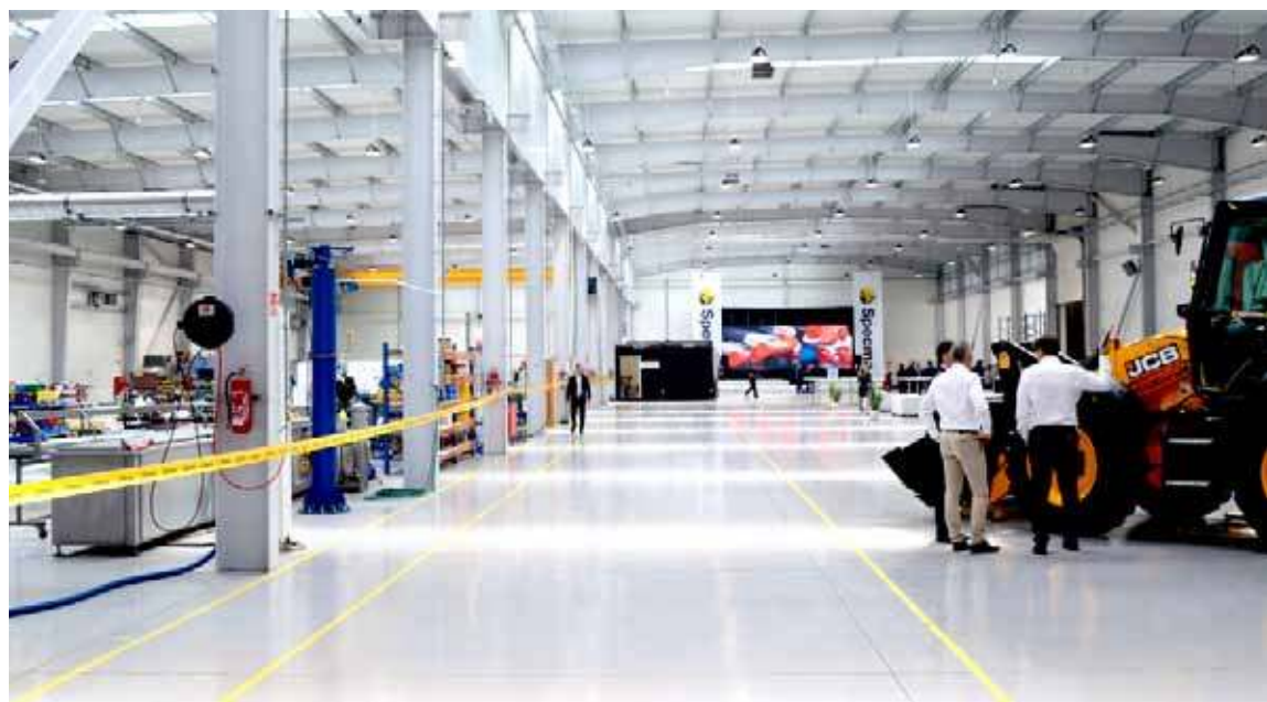
Firma Specma wybudowała nową halę o powierzchni 7 m 2
