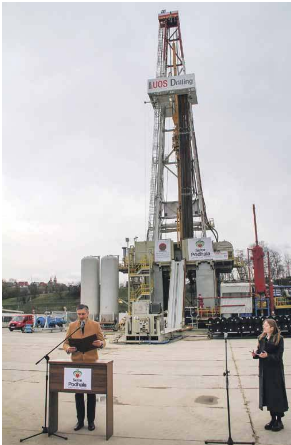
W Szaflarach powstaje odwiert o głębokości 7 km, który ma dostarczyć gorącą wodę z głębin ziemi do sieci geotermalnej.
