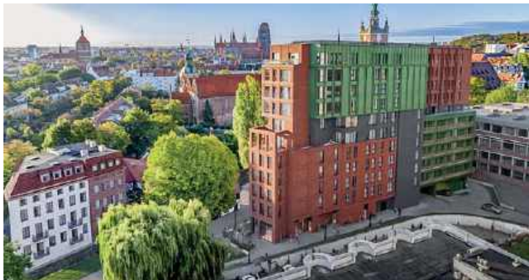
Nowy budynek Wodopój będzie lokalną dominatą
