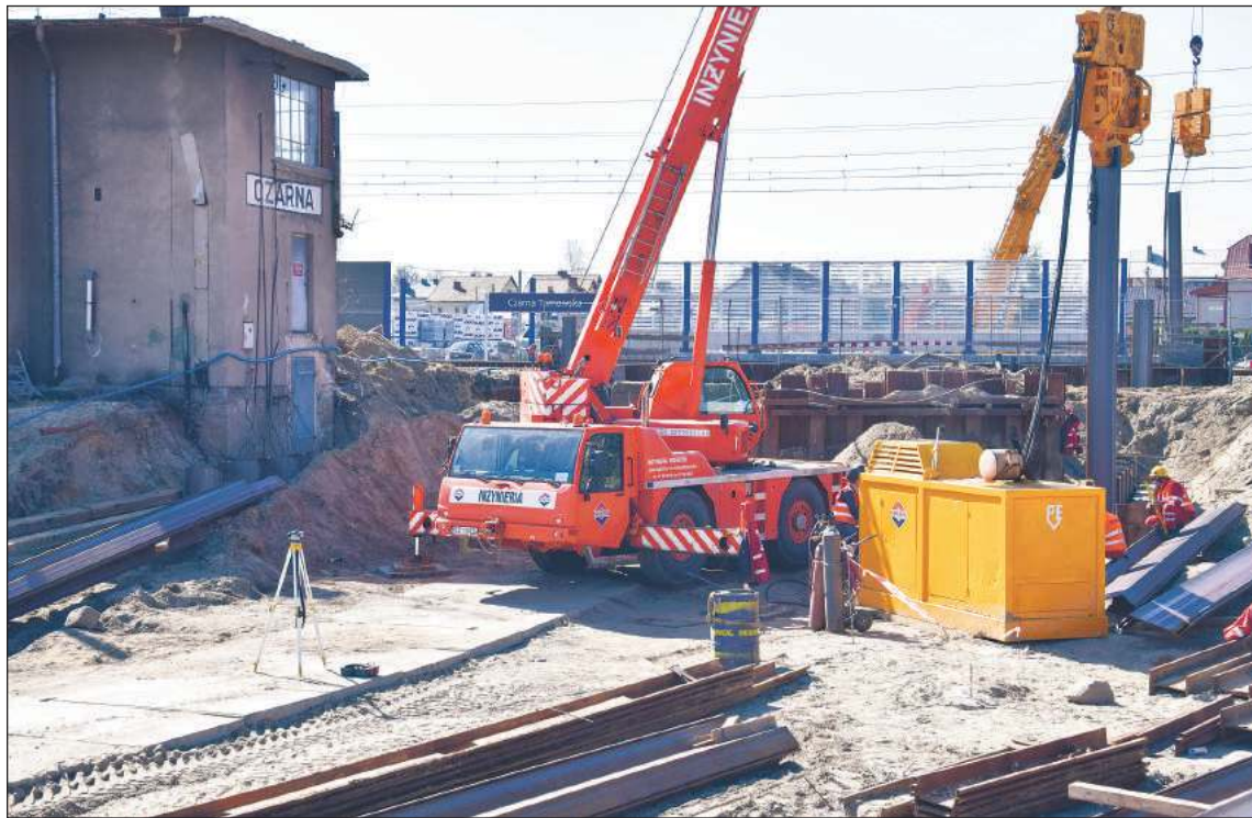
Budowa wiaduktu w Czarnej i jej okolice to wciąż jeden wielki plac budowy. Prace potrwają do końca roku.
