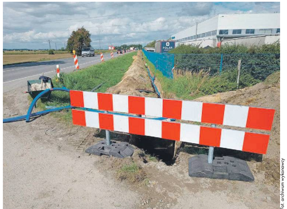
Ruszyły prace związane z budową ścieżki pieszo-rowerowej wzdłuż drogi krajowej nr 94 w Godzikowicach
