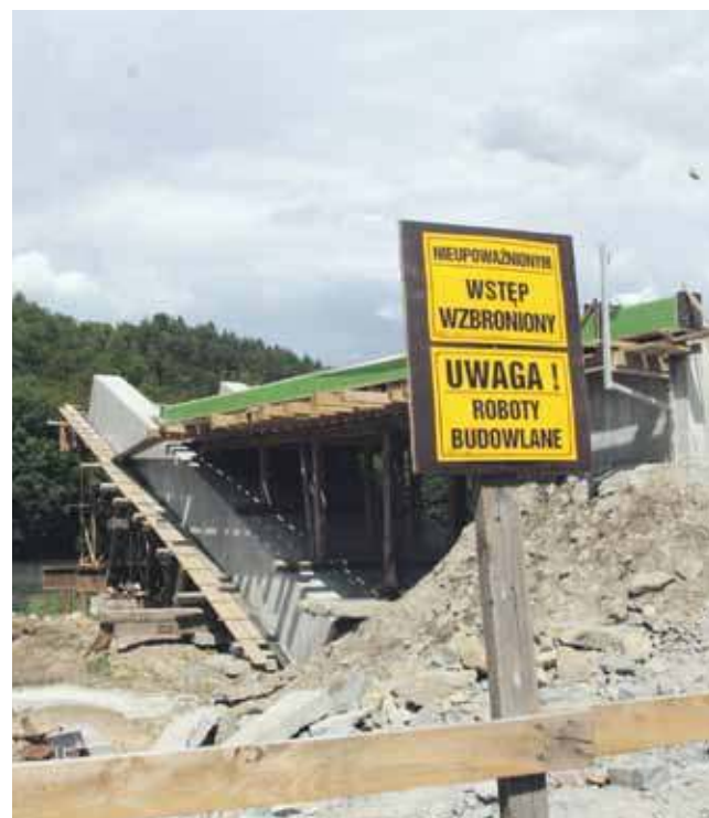
W Tylmanowej praca przy kładce łączącej gminę Ochotnica Dolna z gminą Łącko postępuje.
