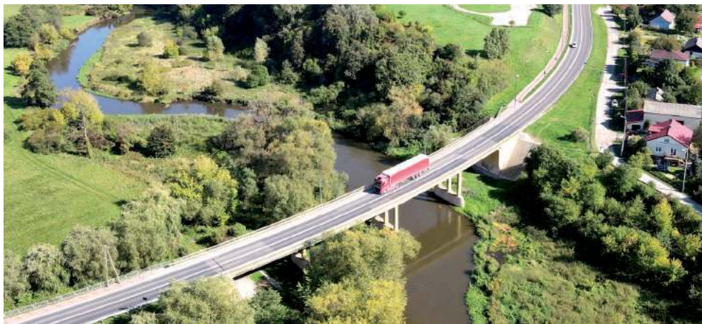
Most w Łęcznej powstał w 1966 roku i jest już w złym stanie technicznym, informując o ogłoszonym przetargu na budowę nowej przeprawy, GDDKiA w Lublinie
