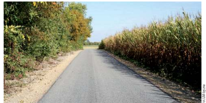
Nowa nawierzchnia na trasie Stara Wieś - Stasin
