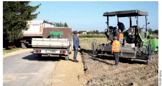
Remonty dróg w sołectwach Witaniów, Stara Wieś - Stasin i Nowogród. Na zdjęciu ekipa remontowa i Leszek Włodarski, burmistrz Łęcznej
