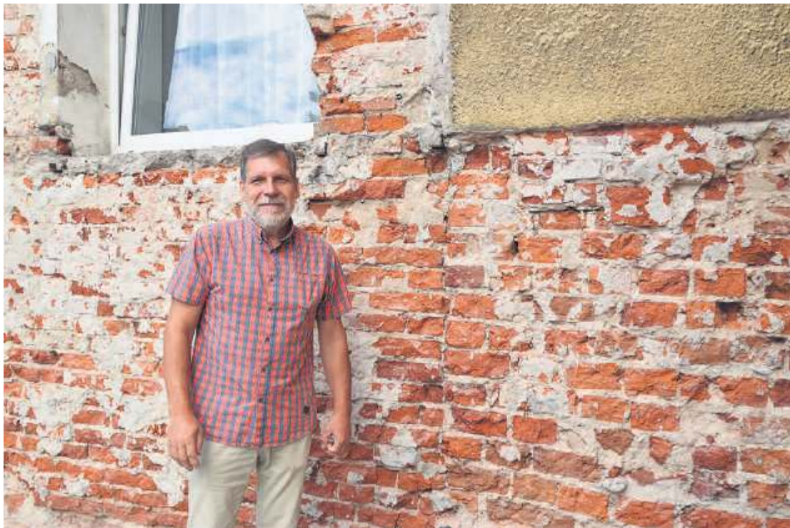
Przy odsłonięciu zabytku ujawniono miejsce styku dwóch murów, dawnego spichlerza i muru obronnego. Na zdjęciu, przy wspomnianym fragmencie, Piotr Mówiński, dyrektor TOK-u.
