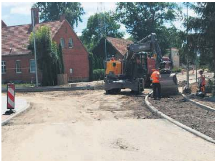
Droga powiatowa. Prace na ulicy Głównej podzielono na dwa odcinki, które wykonuje dwóch różnych wykonawców. – Na odcinku I trwają prace bitumiczne i roboty wykończeniowe. Na odcinku II wykonana została kanalizacja deszczowa. Obecnie trwają prace brukarskie oraz te związane z odtworzeniem konstrukcji po kanalizacji deszczowej – tłumaczy p.o. dyrektora Zarządu Dróg Powiatowych w Tucholi Arkadiusz Malinowski. Fot. softys Suchej Damian Karczewski.
