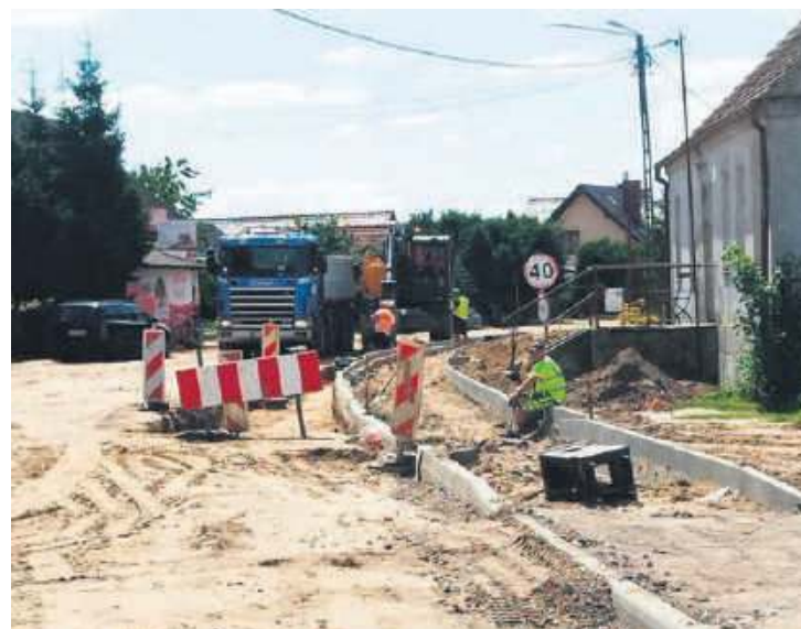
W Suchej na ul. Głównej prace mogą potrwać do 23 października br. – według zapisu w umowie z firmą PBDIM Świecie. Jednak z informacji udzielonej „Tygodnikowi” przez p.o. dyrektora ZDP Arkadiusza Malinowskiego mogą zakończyć się wcześniej. – Jezdnia zostanie poszerzona do 5,5 m. Zaprojektowano obustronne chodniki oraz zjazdy indywidualne. Wybudowana została kanalizacja deszczowa na całej długości jezdni – tłumaczy Malinowski. Fot. softys Suchej Damian Karczewski.
