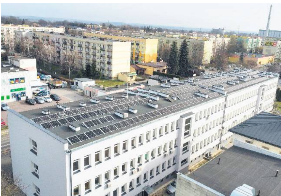
Panele zamontowano na dachu przychodni przy ul. Kilińskiego.
