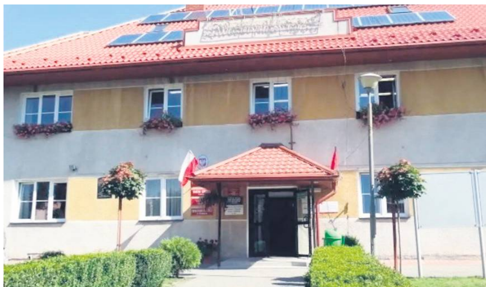
Być może niebawem budynek Urzędu Gminy będzie budynkiem Urzędu Miejskiego.
