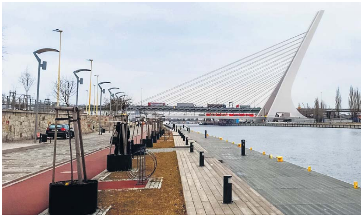
Celem inwestycji jest budowa nowej przeprawy oraz zapewnienie dostępu drogowego do portu
