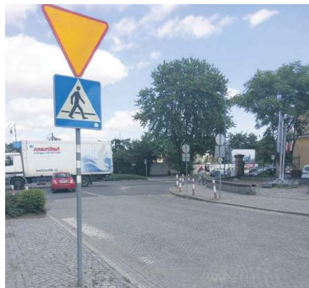
Poziome oznakowanie tego przejścia dla pieszych na ul. Mickiewicza w Strzelinie jest praktycznie niewidoczne
