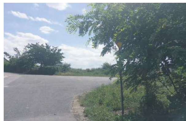
Na skrzyżowaniu ulic Dębowej i Akacjowej w Gęsińcu znak drogowy „ustąp pierwszeństwa” jest ledwo widoczny
