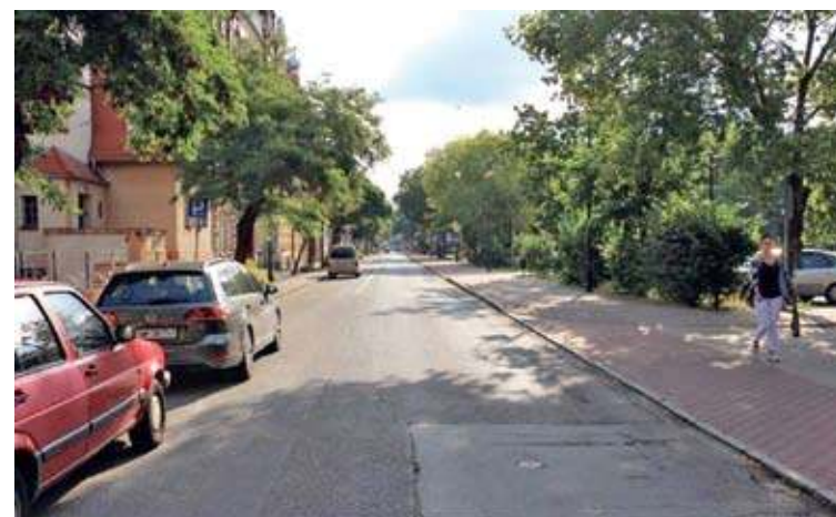
Przebudowa ul. Zjednoczenia pochłonie ok. 3 mln zł
