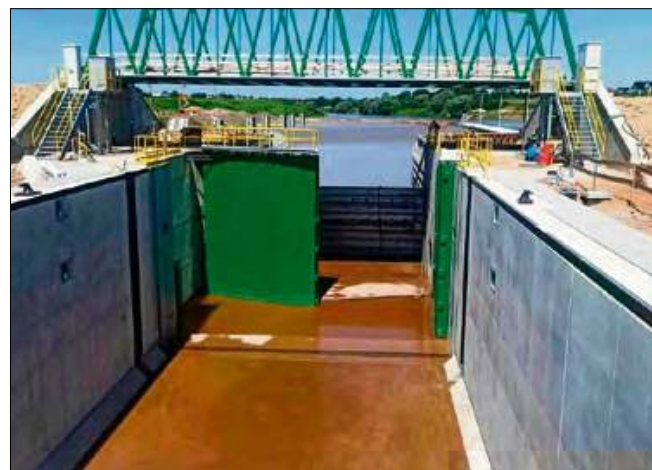
Wypełnienie komory nowopowstałej śluzy odbyło się 17 lipca.
