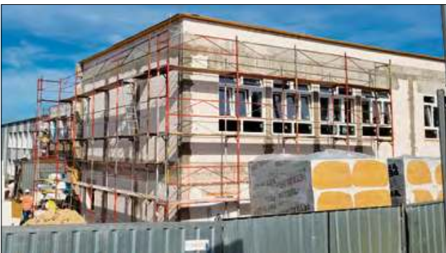
Wiele prac przy budynku Publicznej Szkoły Podstawowej w Malni już udało się wykonać.
