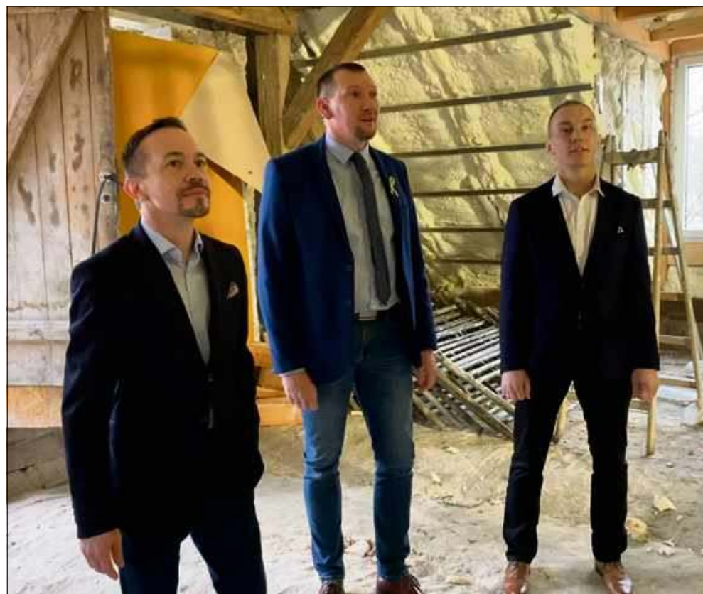
Trwają prace adaptacyjne.
