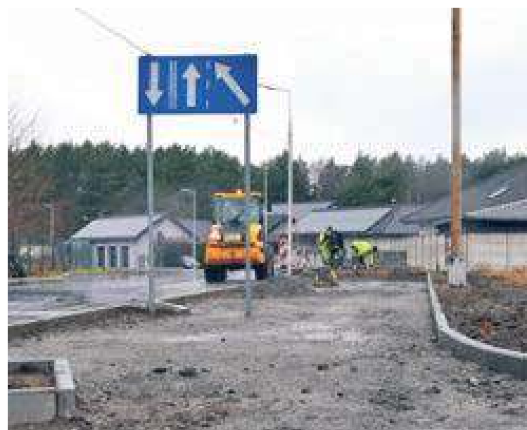
Przebudowa skrzyżowania ul. Okrężnej, Starostawskiej i Granicznej
