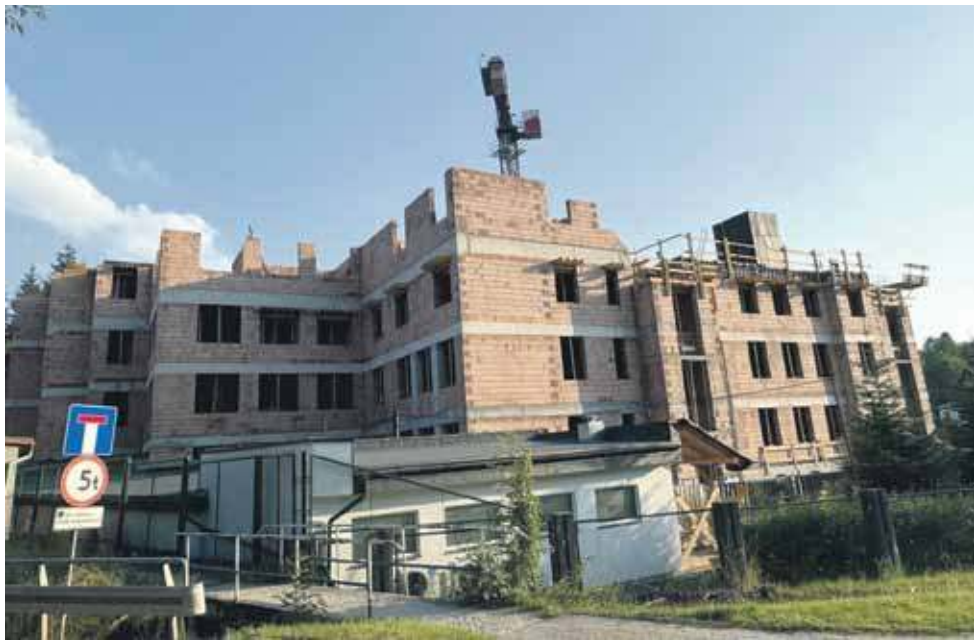
Prace przy odbudowie Szpitala Miejskiego przyspieszyły.
