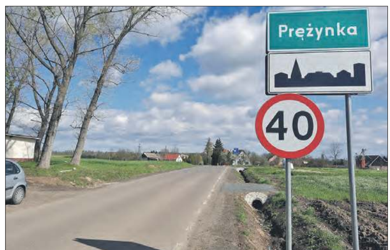
Odnowiona droga łączy Prudnik z Prężynką
