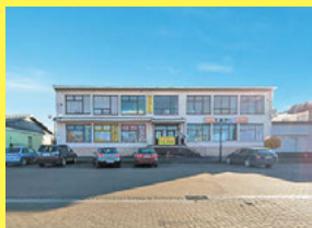
Dom handlowy w samym centrum Janowa Podlaskiego, 885 851 161
