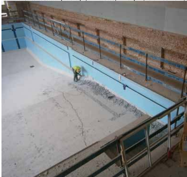
Po modernizacji pływalnia ma być wzbogacona m.in. o funkcje rekreacyjne
