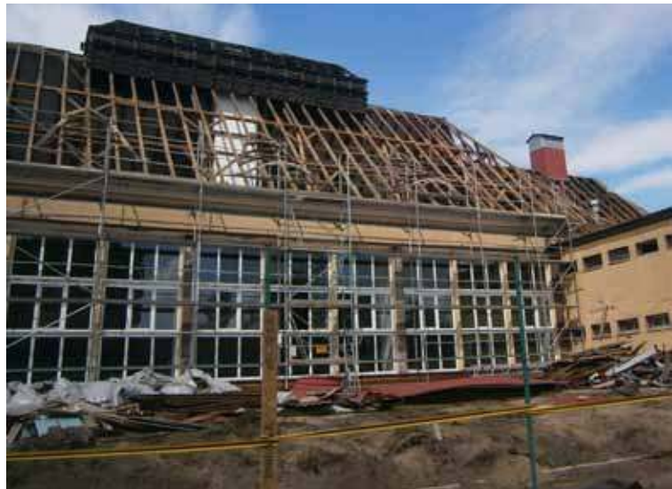
Obecnie trwają prace wyburzeniowe oraz rozbiórkowe
