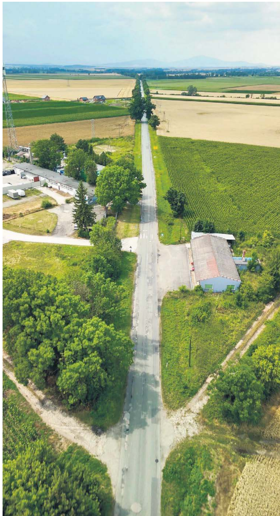
Już niedługo rusza modernizacja kolejnego odcinka DW346
