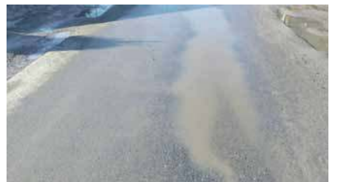
Ul. Partyzantów - w oczekiwaniu na ekipy remontowe.
