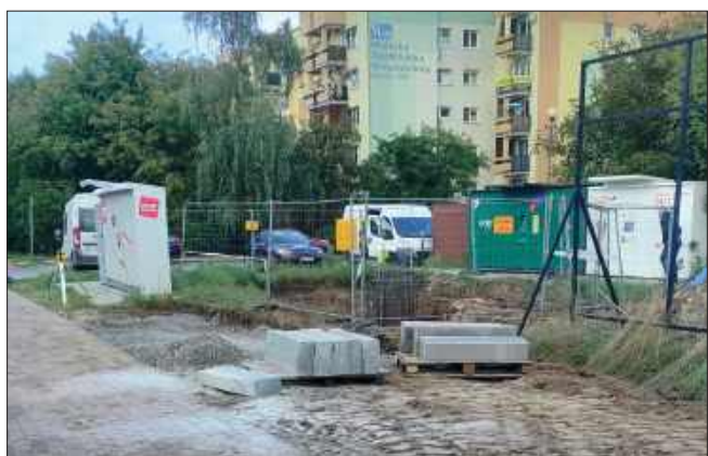
Na Smoczce trwają prace.
