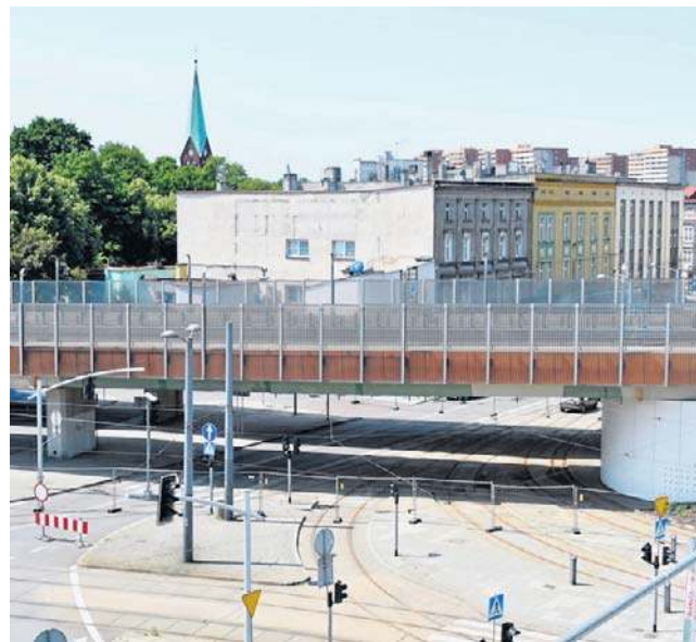
Zanim obiekt zostanie rozebrany, powinno powstać połączenie, które przejmie ruch na ważnej trasie
