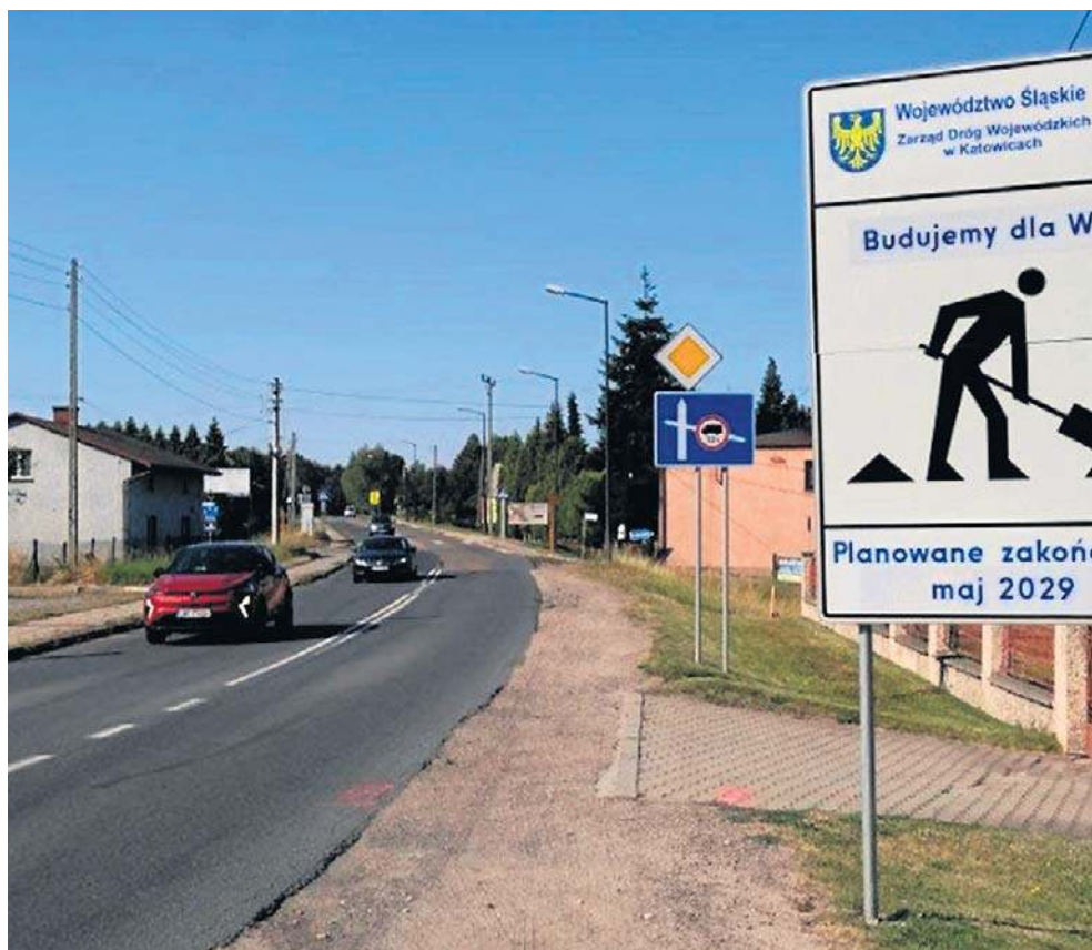
Drogowcy całkowicie wyłączyli z ruchu odcinek DW 935 w Rzuchowie
