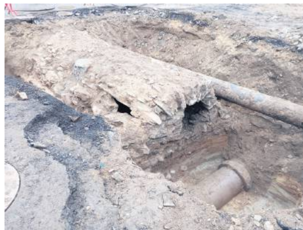
Tajemniczą konstrukcję odkryto tuż pod jezdnią na skrzyżowaniu ul. Wojska Polskiego i ul. Wałowej
