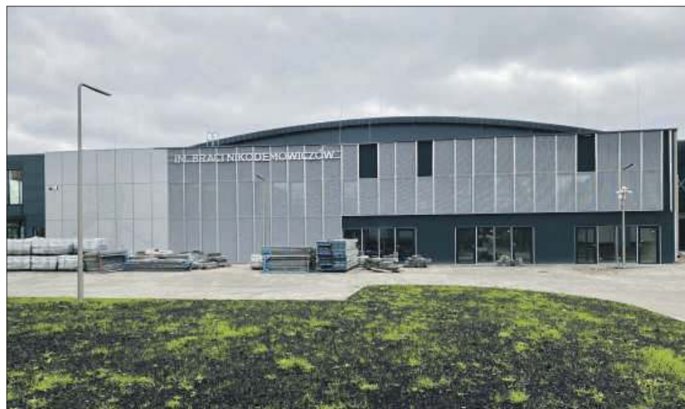
Tak po ściągnięciu rusztowań prezentował się od strony ul. Pułaskiego fronton zmodernizowanego budynku szatniowo-administracyjnego
