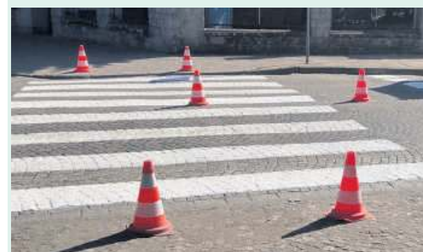
Odświeżone pasy na przejściu dla pieszych na ul. Mickiewicza obok PZLA
