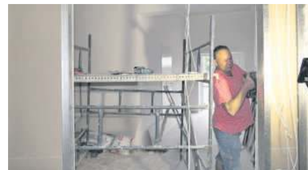
Prace remontowe trwają od miesiąca i mają zakończyć się przed rozpoczęciem nowego roku szkolnego
