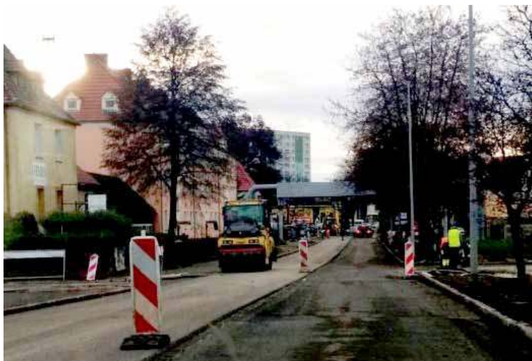
Niekorzystne warunki pogodowe spowodowały, że zakończenie przebudowy ul. Pierwszej Brygady przesunie się o tydzień
