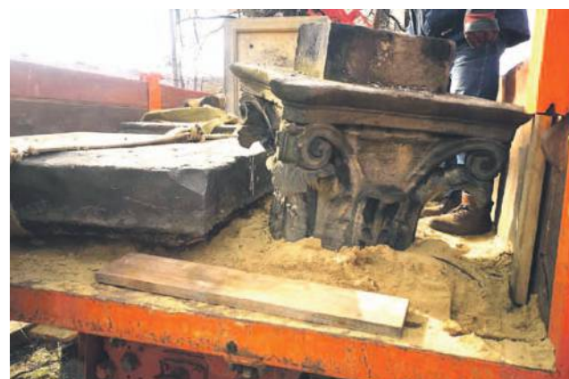
Zdemontowana kolumna trafiła do renowacji
