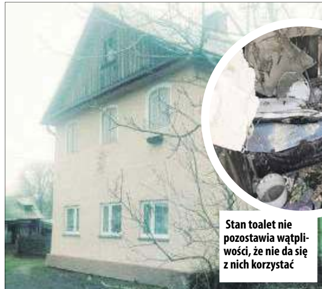
W budynku przy ul. Bialskiej 15 w centrum Leśnej Podlaskiej mieszka pięć rodzin, jednak warunki, w jakich żyją budzą trwogę
