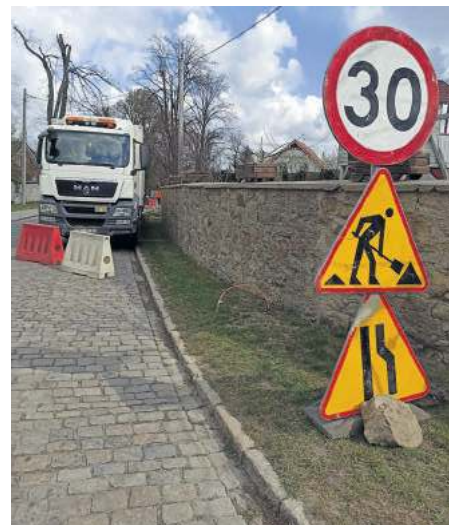
Na czas prac na ul. Lipowej w Gęsińcu wprowadzono niewielkie ograniczenia w ruchu
