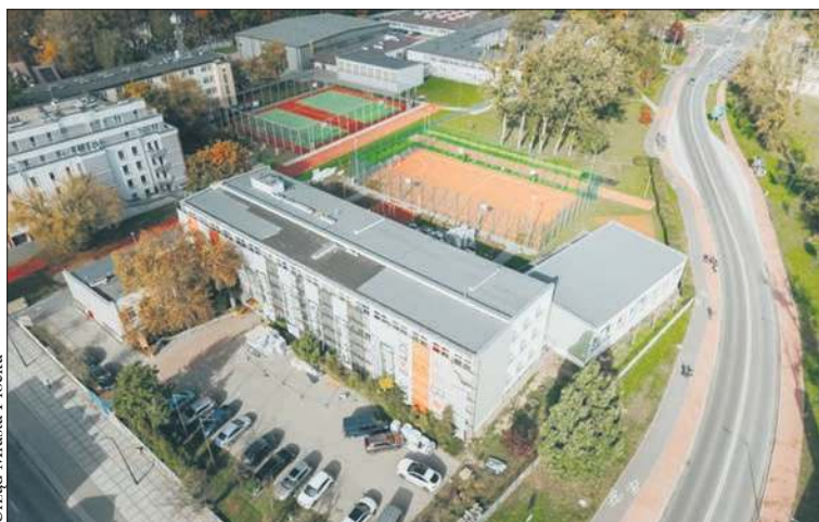
Dobiega końca termomodernizacja budynku płockiego „Ekonomika”
