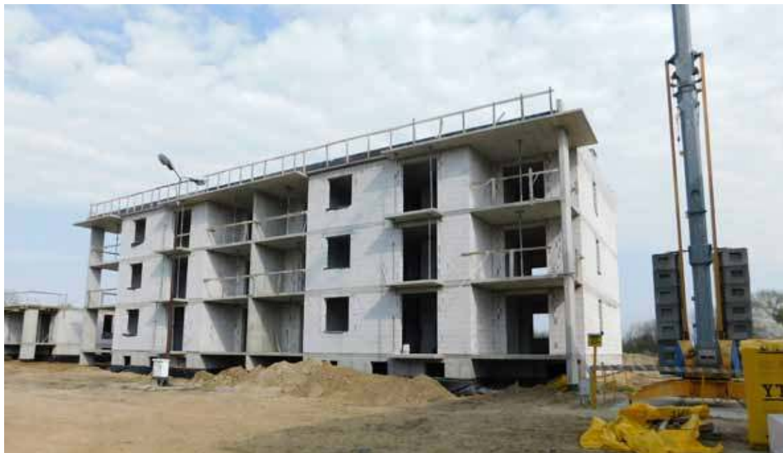
Jeden z sześciu nowo powstających budynków
