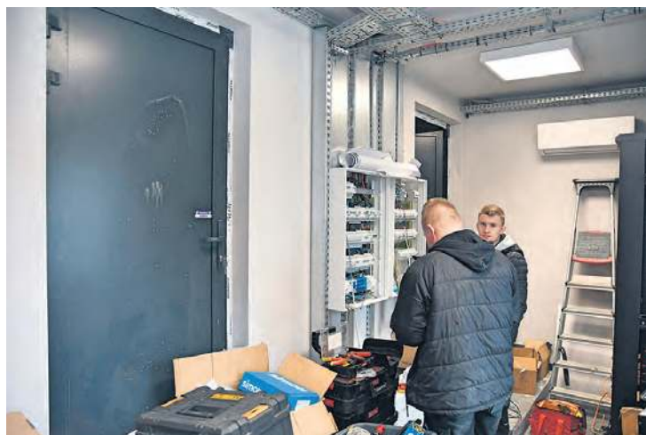
Aktualne prace dotyczą m.in. elektryki w obiekcie.
