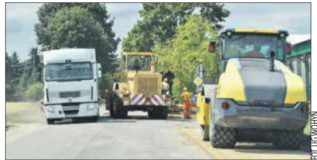
Przebudowany zostanie odcinek ponad 10 km na trasie Marynin – Wohyń
