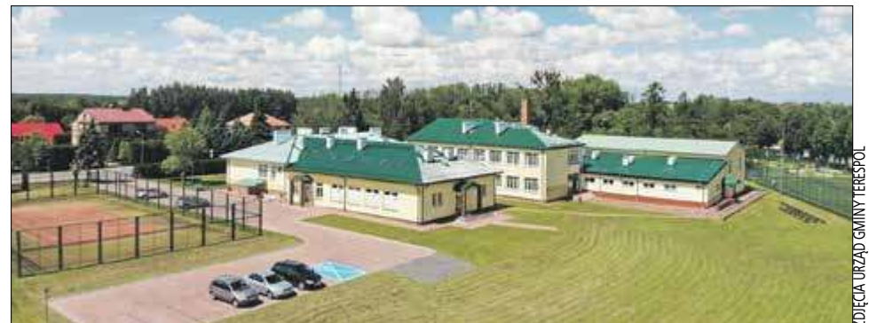
Ważnym przedsięwzięciem był też projekt pod nazwą: „Rozbudowa budynku Zespołu Szkół im. Orła Białego w Kobylanach o oddział przedszkolny”
