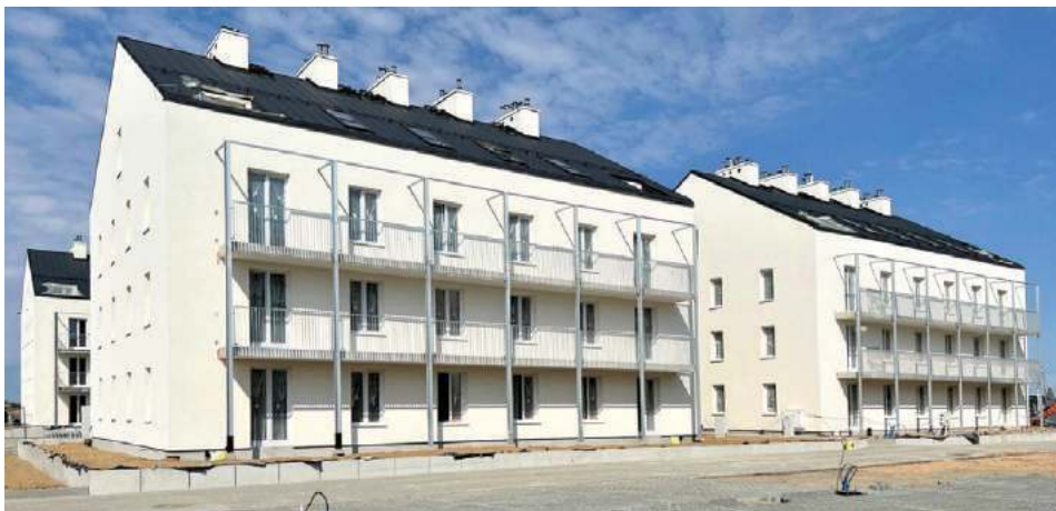
Przy ul. Parkowej powstaje sześć czterokondygnacyjnych budynków o dwuspadowych dachach.
