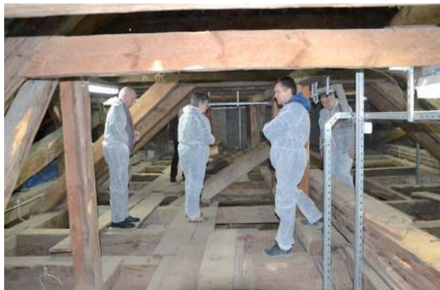
Podczas oględzin kościoła zainteresowano się m. in. poddaszem. Konserwator chciał sprawdzić, czy rzeczywiście historyczna więźba dachowa nie zachowała się w odpowiednim stanie i trzeba będzie ją wymienić. Okazuje się jednak, że wiele oryginalnych elementów uda się zachować
