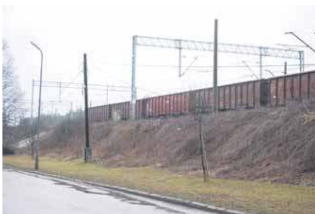
Wiadukt ma wznosić się kilka metrów nad nasypem, który już i tak jest usytuowany kilka metrów powyżej ulicy
