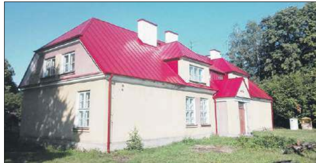
W wyremontowanym budynku mieści się świetlica wiejska
