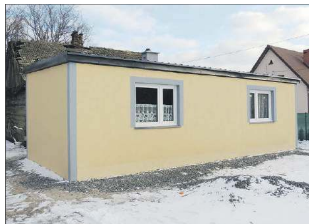
Nowy dom ma 35 mkw. powierzchni i jest zbudowany z pustaków. Ma dach z blachy, został ocieplony, wstawiono też okna i drzwi
