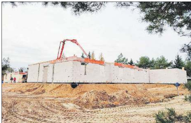
Kontynuowana będzie przebudowa budynku w Strzaskach
