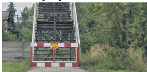
Przejścia nad torami nie ma
