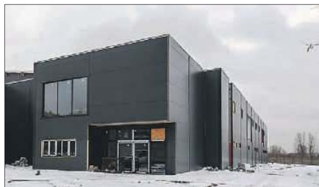
Widok na północno-zachodni narożnik hali lodowiska
