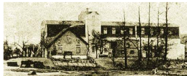
Na miejscu bratiańskiego zamku pobudowano niegdyś młyn, którego budowla stoi do dzisiaj
