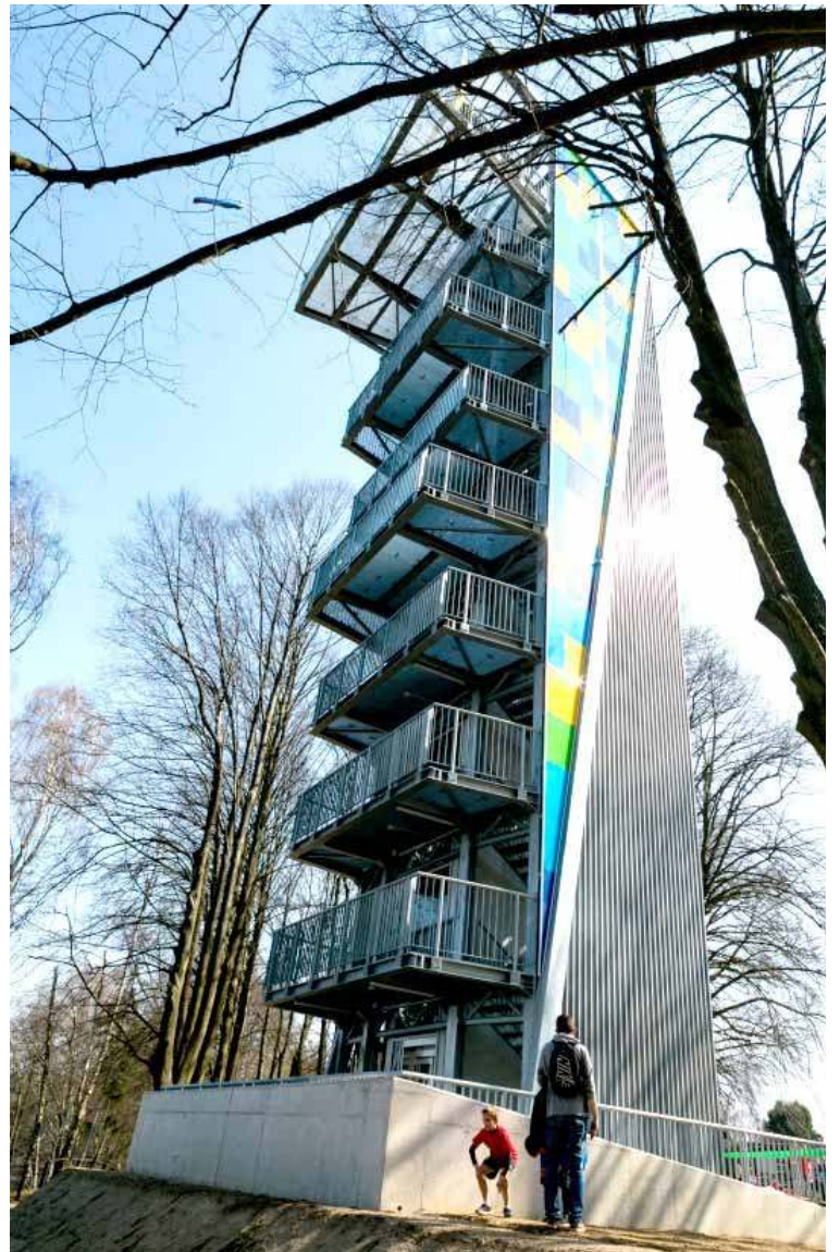
Wieża widokowa ma stalową, ażurową konstrukcję o wysokości 30 metrów
