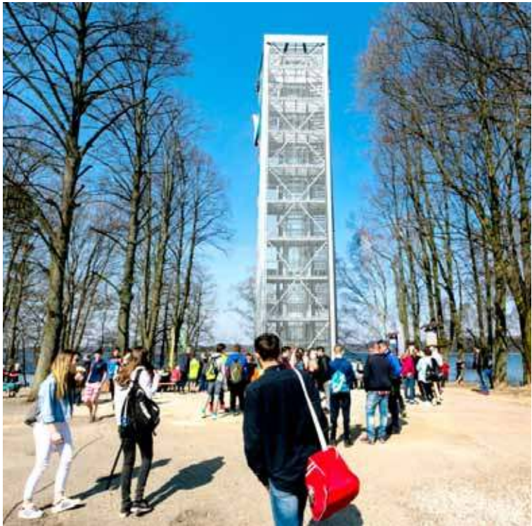
Obiekt ma 8 pięter i wyposażony jest w schody oraz windę. Budowa kosztowała 3,4 mln zł
