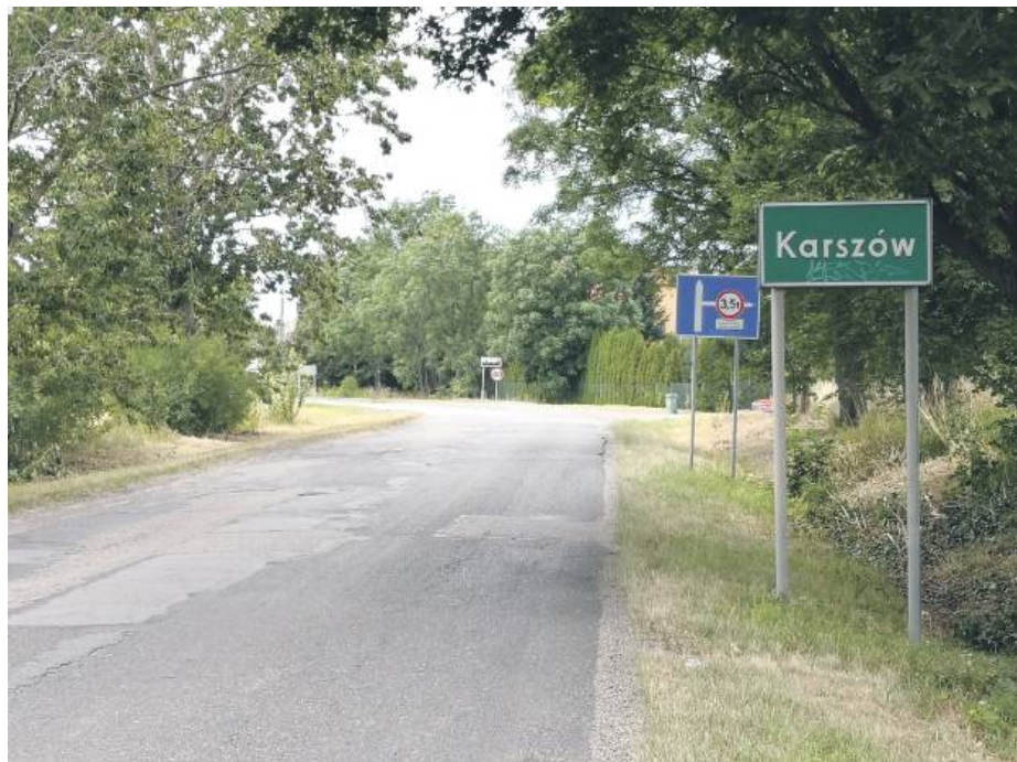
W pierwszej połowie października przebudowywany odcinek drogi relacji Mikoszków – Karszów zostanie zamknięty
