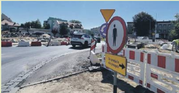
Na remontowanym rondzie został otwarty wjazd od ulicy Ząbkowickiej
