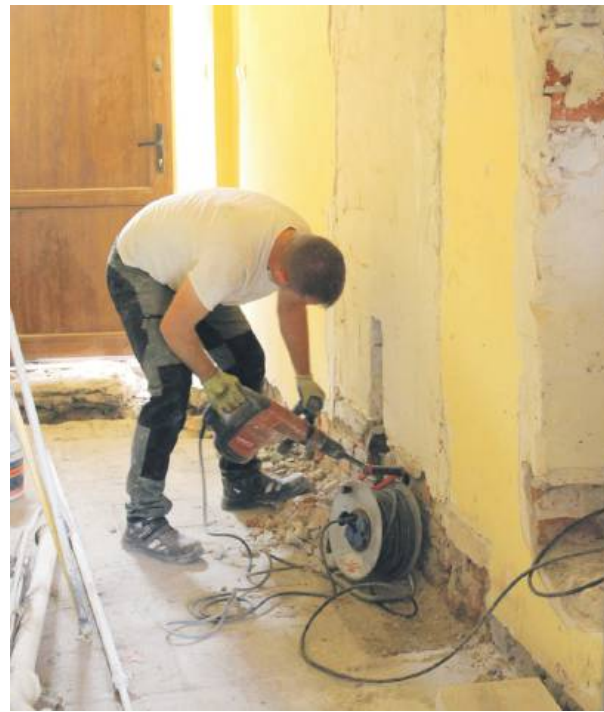
W Urzędzie Gminy w Borowie trwa remont. Fot. UG Borów
