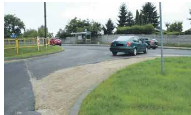
Kierowcy skarżą się też, że wyjazd na Bytomską wciąż jest niedokończony
