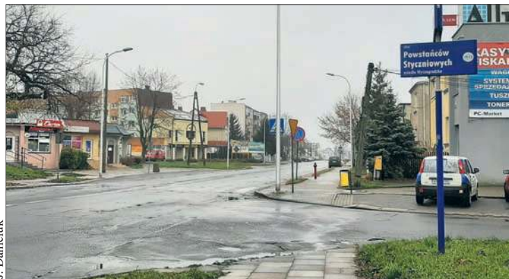
Trwają przygotowania do przebudowy ulicy Spółdzielczej
